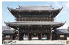
御影堂門 (2015年12月に修復完了)
